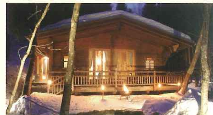
Waldsauna mit Freiluft-Terrasse © www.biohotel-daberer.at
